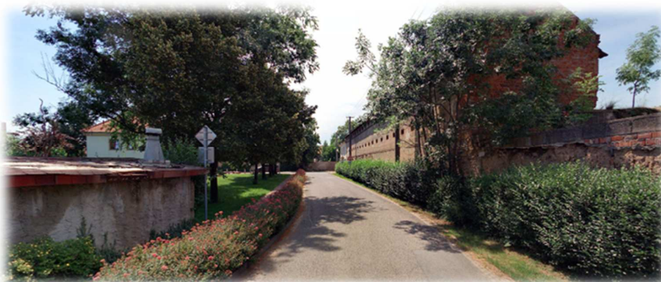
Obr: Severní pohled na hlavní hospodářský objekt souboru staveb plochy Z4/1.
